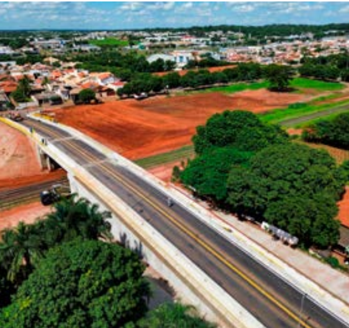
O viaduto será uma continuação da Rua Dois, onde cruza com a Avenida Jânio Quadros e segue por cima da linha férrea até a Rua Oswaldo Cruz, no Jardim Aclimação
