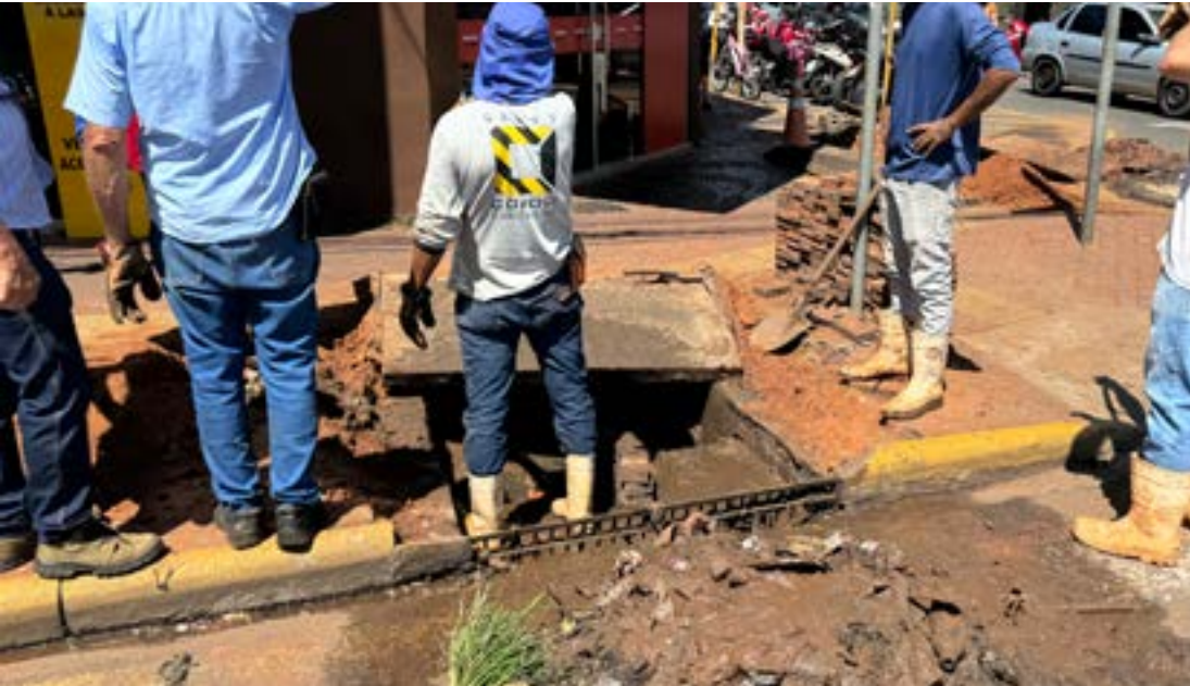
Os trabalhos iniciados na manhã dessa segunda-feira (11) foram realizados no cruzamento da Avenida Francisco Jalles com a rua 10 e se estenderão para outras áreas
