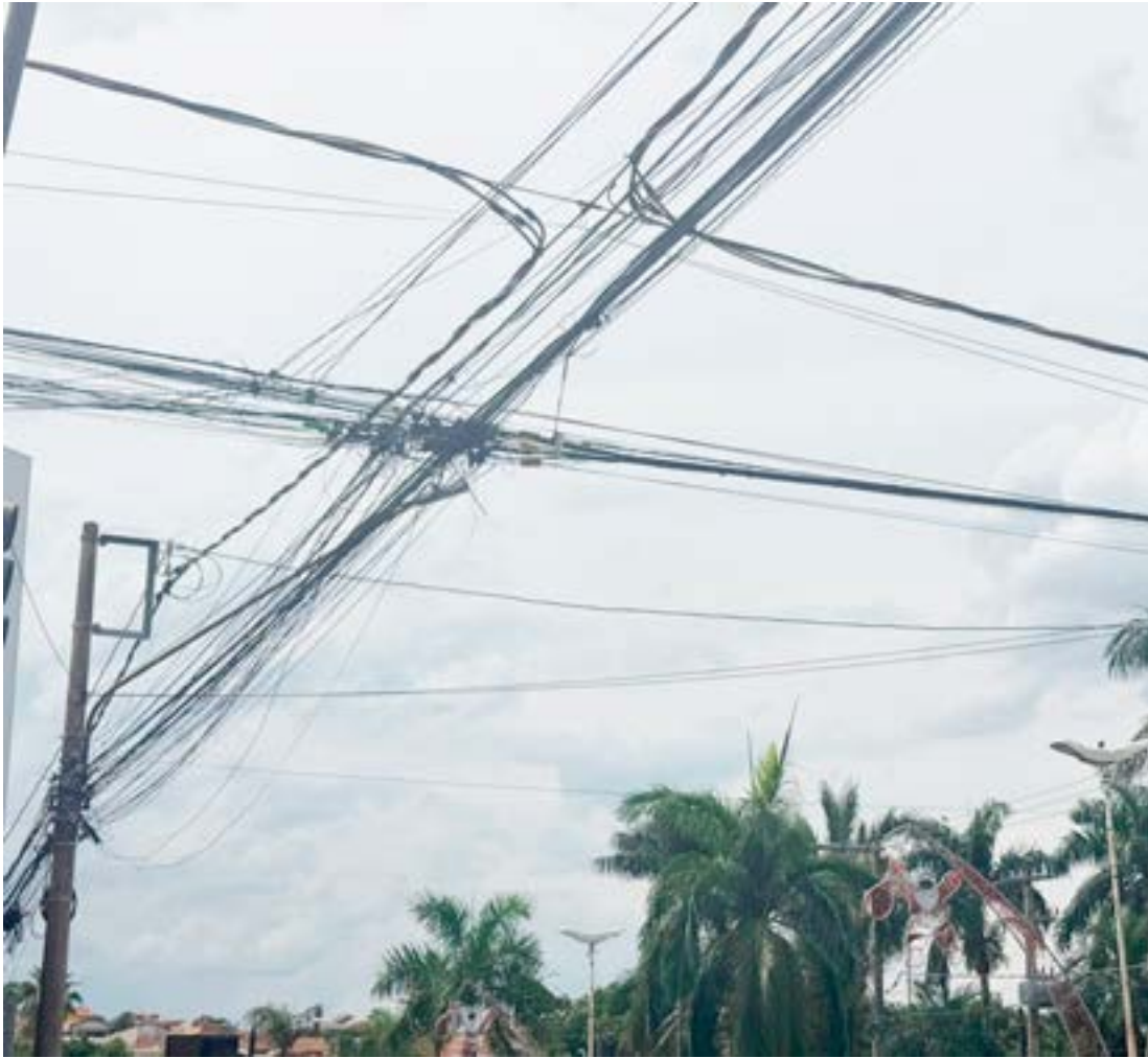
O projeto tem como foco a limpeza de postes e a remoção de cabos de telecomunicação inutilizados na cidade
