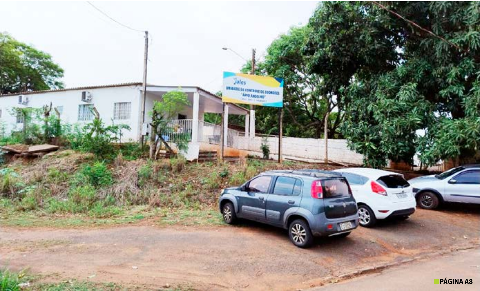
Ao lado da atual Unidade de Zoonoses, a Prefeitura vai construir uma nova sede com investimento de cerca de R$ 930 mil
