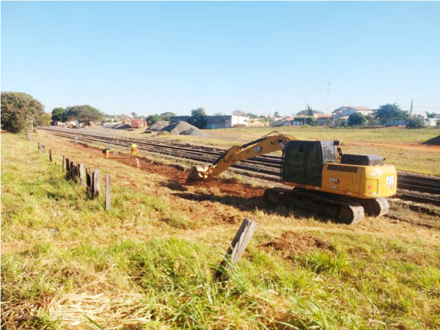
Maquinário e homens já atuam no trabalho de terraplenagem das margens da linha férrea, entre a Avenida Jânio Quadros e a Rua Oswaldo Cruz
