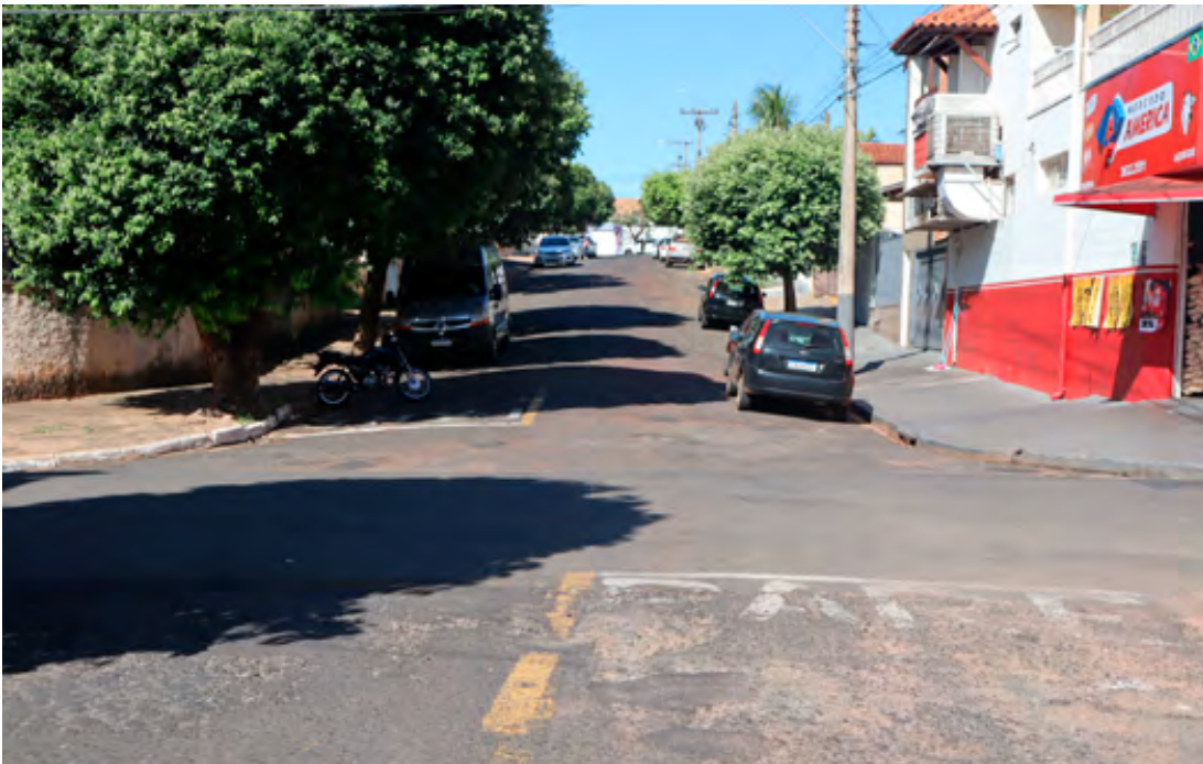
Antes de trechos da Rua Vicente Leporace, uma das vias que receberam obras de recuperação asfáltica com recursos destinados pelo deputado Fausto Pinato
