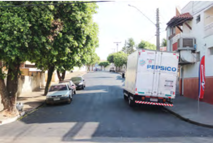
Depois de trechos da Rua Vicente Leporace, uma das vias que receberam obras de recuperação asfáltica com recursos destinados pelo deputado Fausto Pinato
