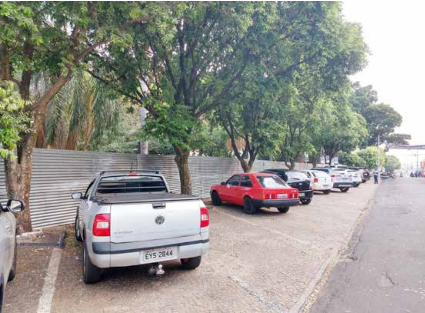
A praça João Mariano de Freitas foi totalmente cercada nesta semana para o início da reforma geral que vai custar R$ 1.520.000,00, sendo R$ 615 mil provenientes do MIT
