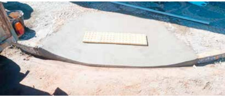
As rampas estão sendo construídas de acordo com a Norma de Acessibilidade 9050-2015 da ABNT
