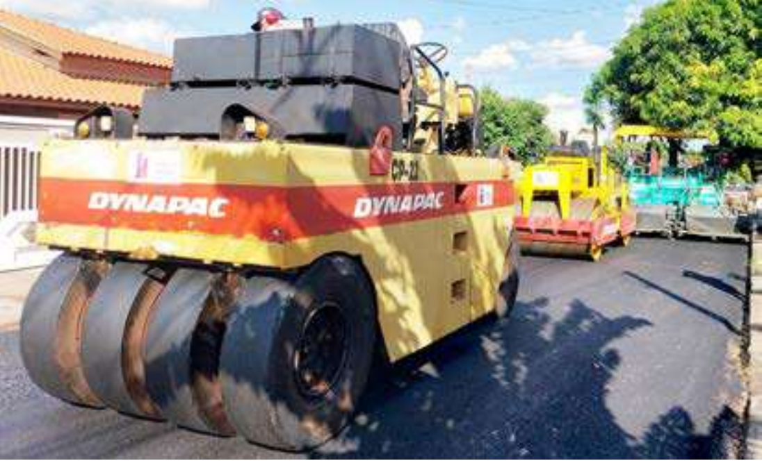
Máquinas e operários trabalham em ritmo acelerado em diversos pontos da cidade
