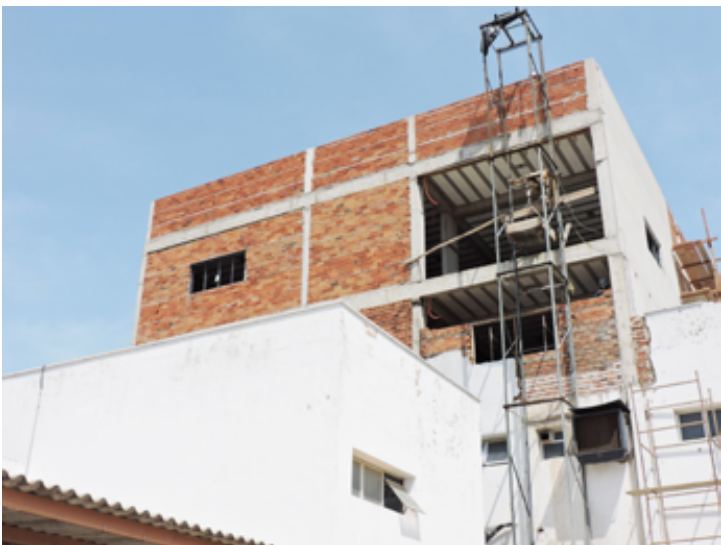
Mais dois pavimentos, que vão totalizar 500m 2 estão sendo construídos na Santa Casa
